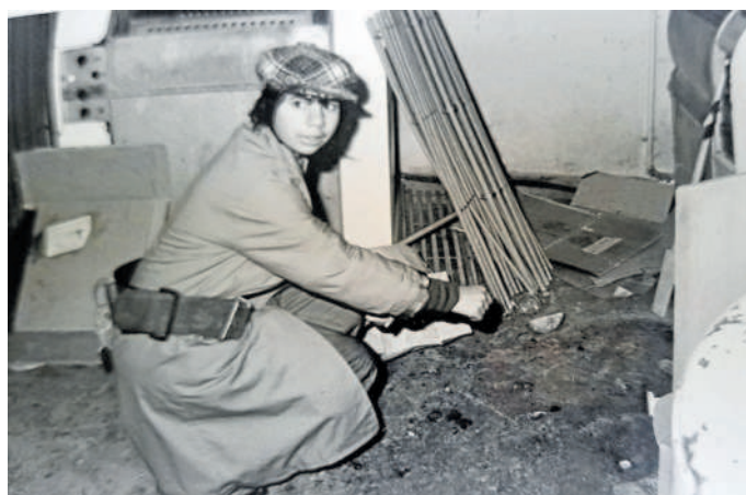
ŽHÁŘKA. Eva Kováčová ukazuje v prádelně místo, kde zapálila složené prádlo. Zdroj: Vyšetřovací spis v ABS v Kanicích u Brna
